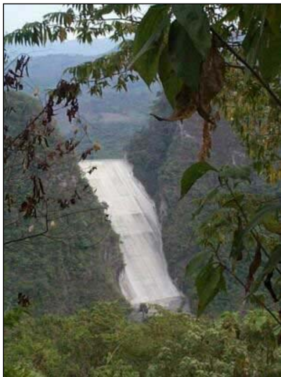
Represa Yacambú-Quibor actualmente en construcción
