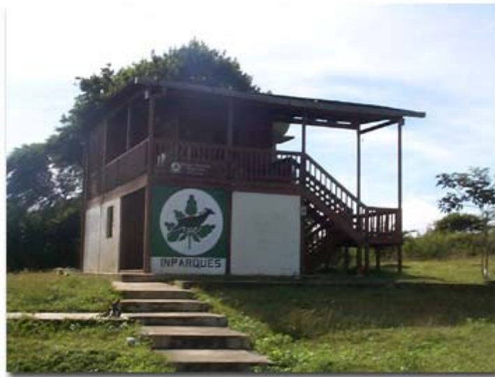
Puesto de Guardaparques en la entrada principal del parque. Este es el único puesto de guardaparques funcionando adecuadamente (foto: César Aponte).
