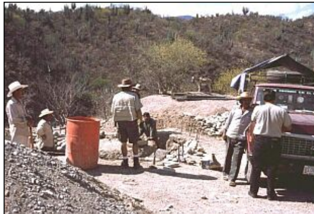
Construcción de casetas de vigilancia
