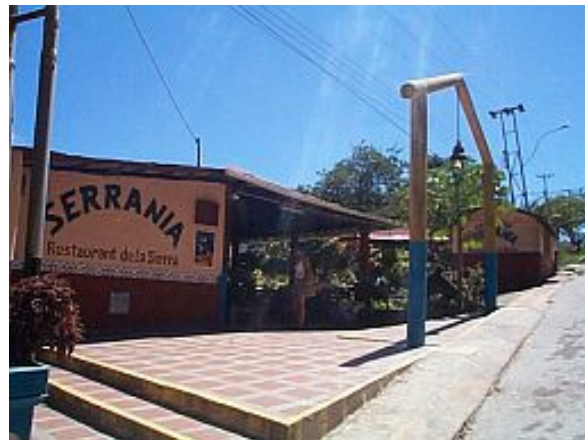
La construcción ilegal del restaurante causó malestar en INPARQUES y también entre los pobladores de La Sierra.
